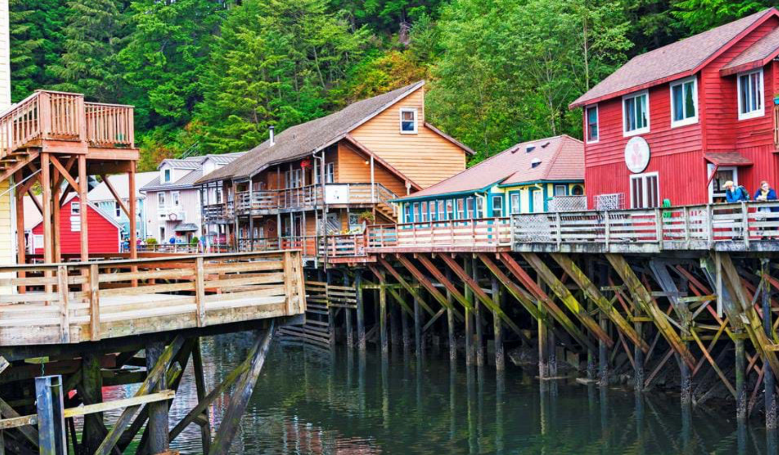
Trehus som er bygget på påler, Ketchikan i Alaska
