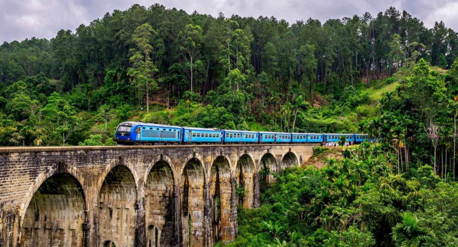
Med tog over 9 Arch Bridge
